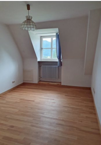
Parkettboden im Clusterzimmer
