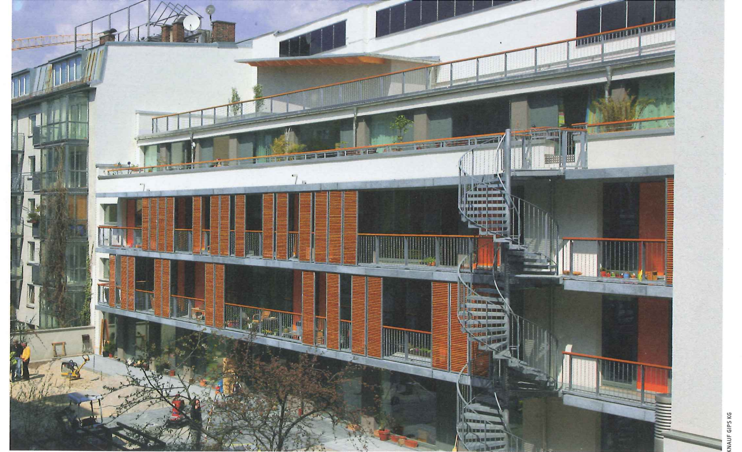
Das vierte Geschoss springt zurück, ermöglicht Dachterrassen und lässt mehr Licht in den engen Hinterhof. Ganz oben ist eine gemeinschaftliche Dachterrasse
