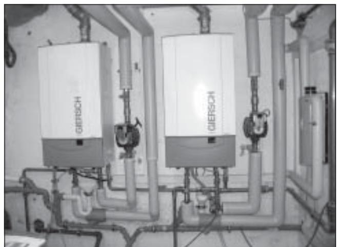
Spitzenlastthermen (2\* 65 KW), die zugeschaltet werden, wenn die Gasmotoren nicht ausreichend Abwärme für Heizung und Warmwasser produzieren
