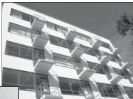
der extrem hohen Raumtemperaturen in den Arbeitsräumen, die, wie unsere Führerin versicherte, im Winter ebenso extrem niedrig sind, da es bedingt durch die Stahl-Glas-Konstruktion keine Isolation gibt.
