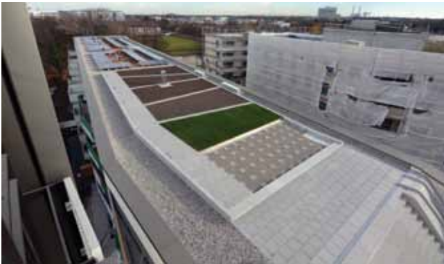
Auf dem Dach: PV-Anlage, Beete und eine Terrasse für die Hausgemeinschaft
