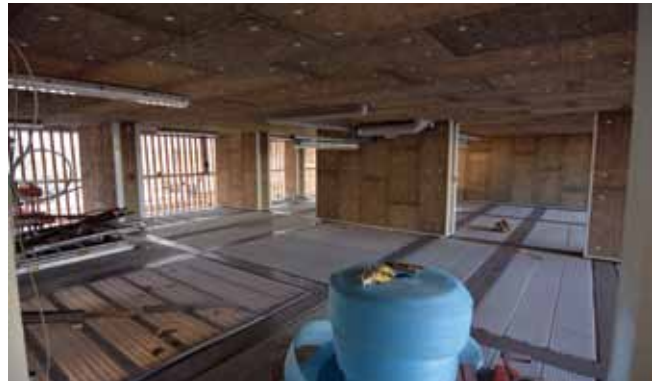
Fahrradgarage: hier im Fahrradparkhaus werden auf 3 Ebenen bald 200 Fahrräder abgestellt sein
